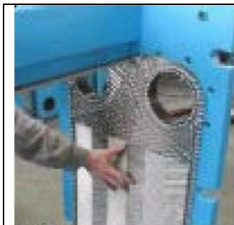
Рис 6.11. Монтаж первой пластины
