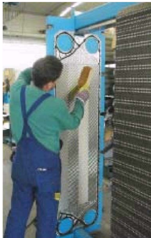
Рисунок 6.6. Очистка поверхности пластины с помощью мягкой щетки.
